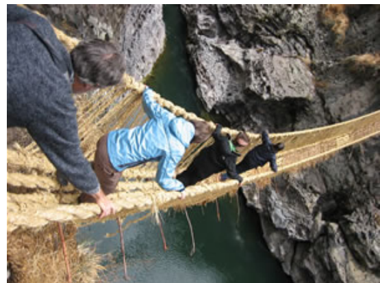
Figura 3. Ponte tipo inca, mostrando detalhes da grossura dos cabos.
